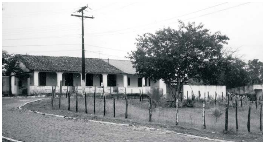
FOTO 2 - Habitação dos técnicos da Usina Cinco Rios
