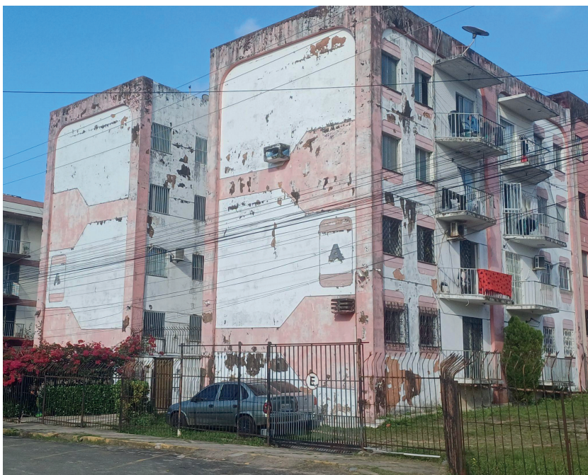
Figura 03 - Vista dos Bloco A e B do condomínio Buena Vista.
