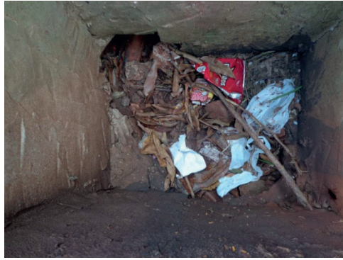
Figura 7 - Resíduos sólidos encontrados antes da instalação do cesto coletor dentro da rede de drenagem
