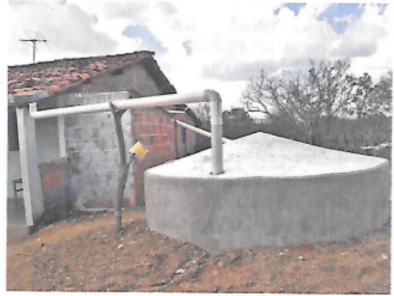
Casa em Juazeiro, sertão da Bahia, 2008, com cisterna construída através do Projeto Cisternas, fruto de parceria entre poder público, empresas privadas e universidades do Nordeste.
