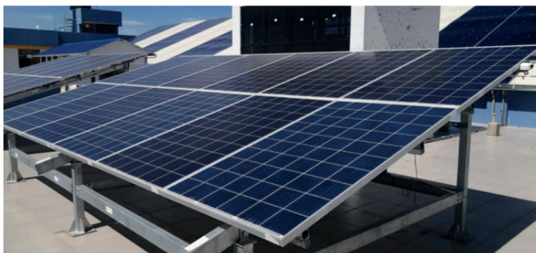
Figura 25 - Vista parcial de los paneles instalados.
