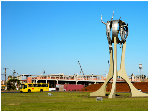
Figura 9 – Construção do Boulevard Londrina Shopping, em 2011
