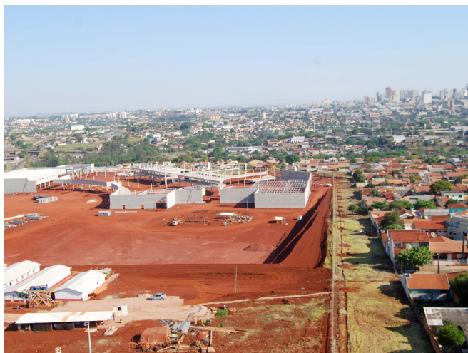
Figura 7 – Construção do Londrina Norte Shopping, em 2011
