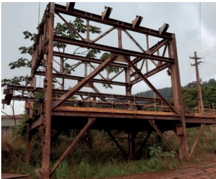
Figura 16: Estrutura metálica para instalação de um hope
