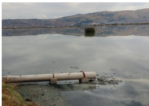
Figura 1. Laguna de oxidación de Puno.
