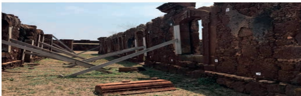
Figura 7: Vista de conjunto de edificações na praça de armas com escoramentos aplicados. Fonte: Arqueolog, Pesquisa, 2020.
