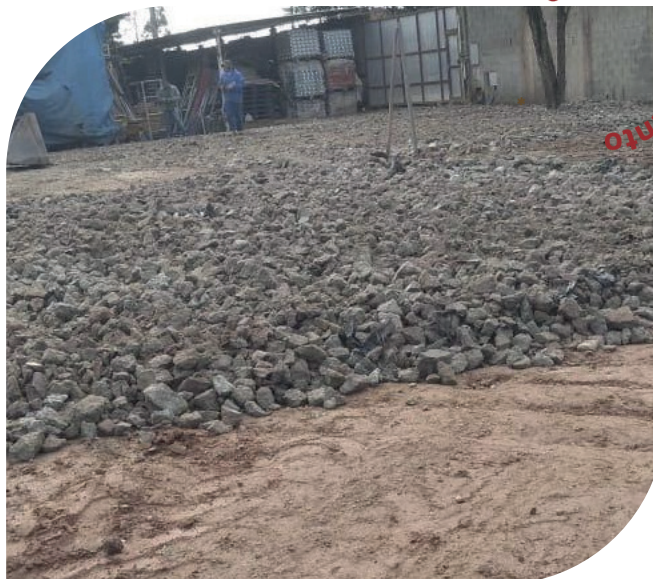
Figura 57 – Exemplo de elevação de greide (cota), para viabilizar aterros ou camadas de pavimento. Fonte: ABRECON.
