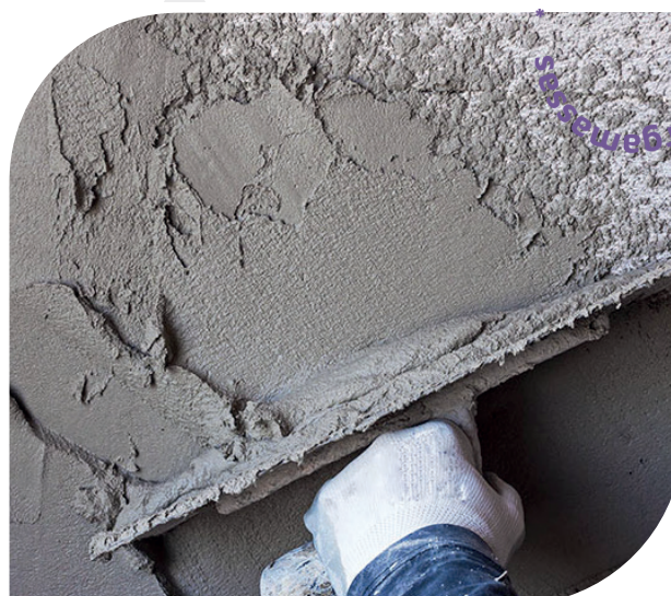
Figura 28 – Sistema de revestimento de argamassa tradicional. Fonte: google imagens, ABRECON.
