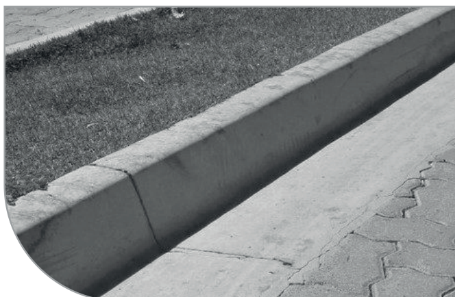
Figura 32 – (esquerda) sarjeta com concreto extrudado in loco. (direita) guia pré-fabricada. Fonte: google imagens.
