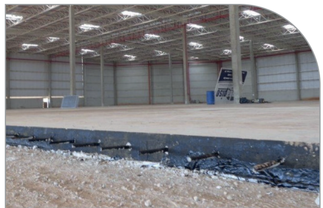
Figura 42– Camadas do piso de concreto para fins industriais. Fonte: google imagens.
