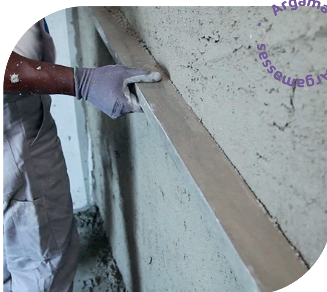
Figura 29 – Revestimento de argamassa: camada única. Fonte: ABRECON.
