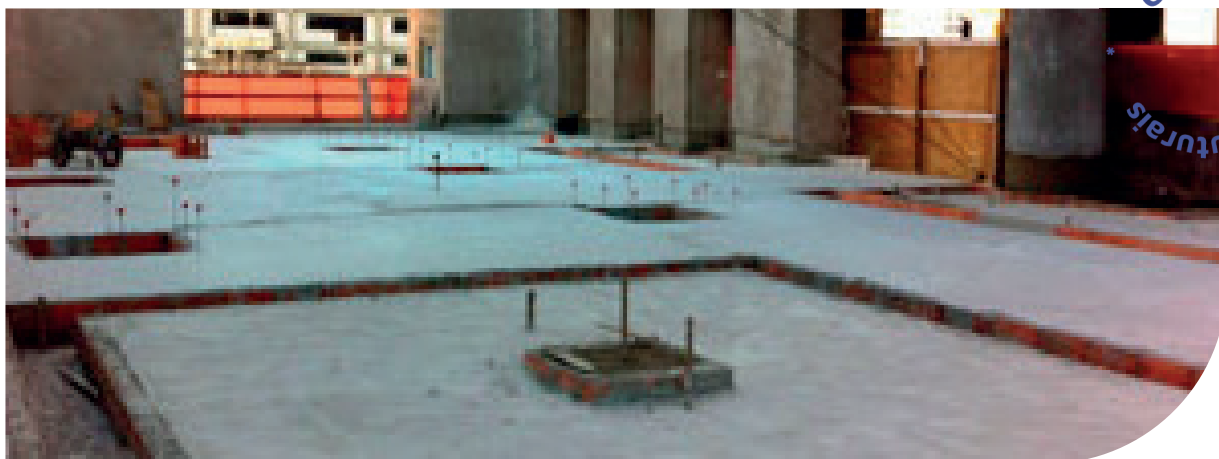
Figura 38 – Concreto de enchimento usado para nivelar áreas externas de edifícios. Fonte: google imagens.
