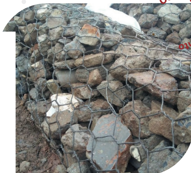
Figura 62 – Trincheira drenante especificada no projeto de urbanização. Fonte: IPT, ABRECON.
