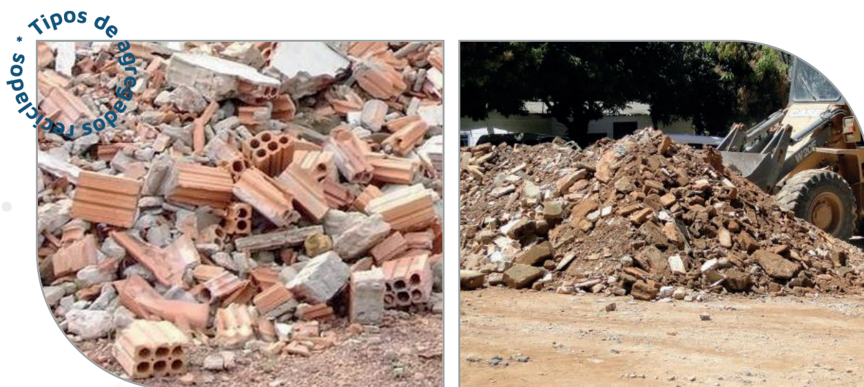
Figura 2– RCD misto: demolição de alvenaria de blocos de cerâmica vermelha, misturado com solo de escavação e diversas impurezas (tubulações de instalações elétricas, de água, madeira, metais. Fonte: google imagens.
