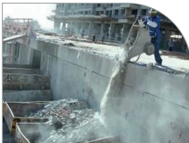
Figura 4 – Resíduo cimentício em usina de reciclagem (à esquerda), constituído por mistura de tipos de argamassas e concretos, diversos não estruturais. Resíduo cimentício de obra (à direita), com quebras de blocos de concreto e sobras da execução de serviços de argamassa (maior concentração de fração fina no material). Fonte: google imagens.
