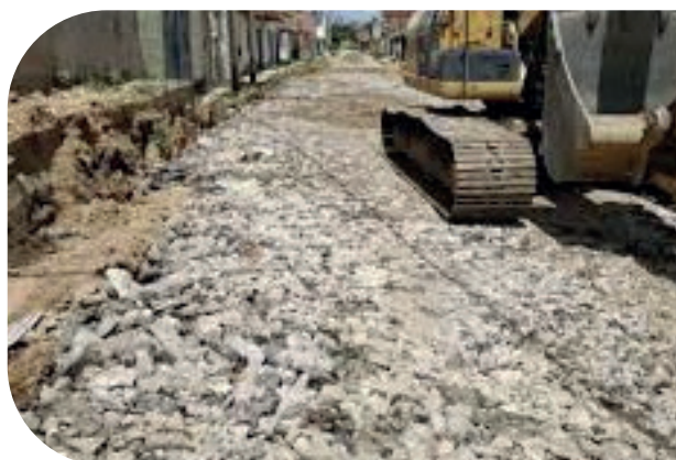
Figura 19 – Obra de pavimentação: escavação do solo local e reforço do subleito com rachão reciclado misto. Fonte: [35]
