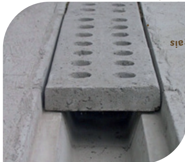
Figura 49 – Grelha perfurada, para proteger galeria e aumentar a infiltração de água de chuva pelo solo, através de um piso drenante. Fonte: ABRECON.
