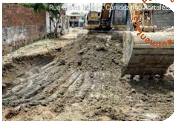
Figura 19 – Obra de pavimentação: escavação do solo local e reforço do subleito com rachão reciclado misto. Fonte: [35]
