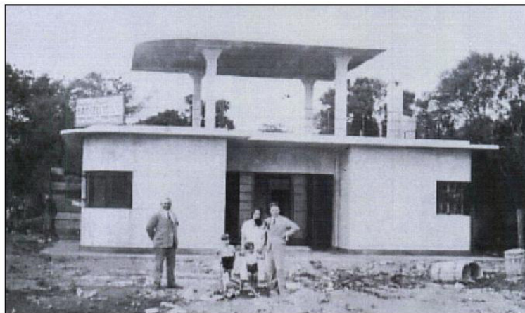
Figura 41 - Casa de Coufal em construção/Ipanema - 1931
