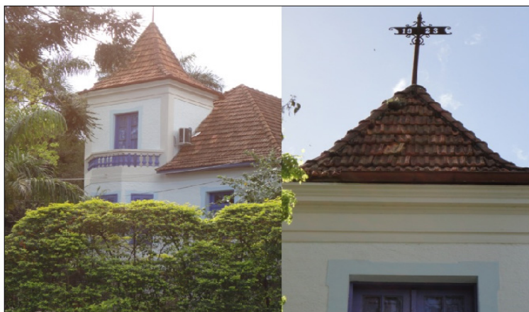
Figura 13 - Palacete dos Dreher/2013. No detalhe o ano da construção: 1923
