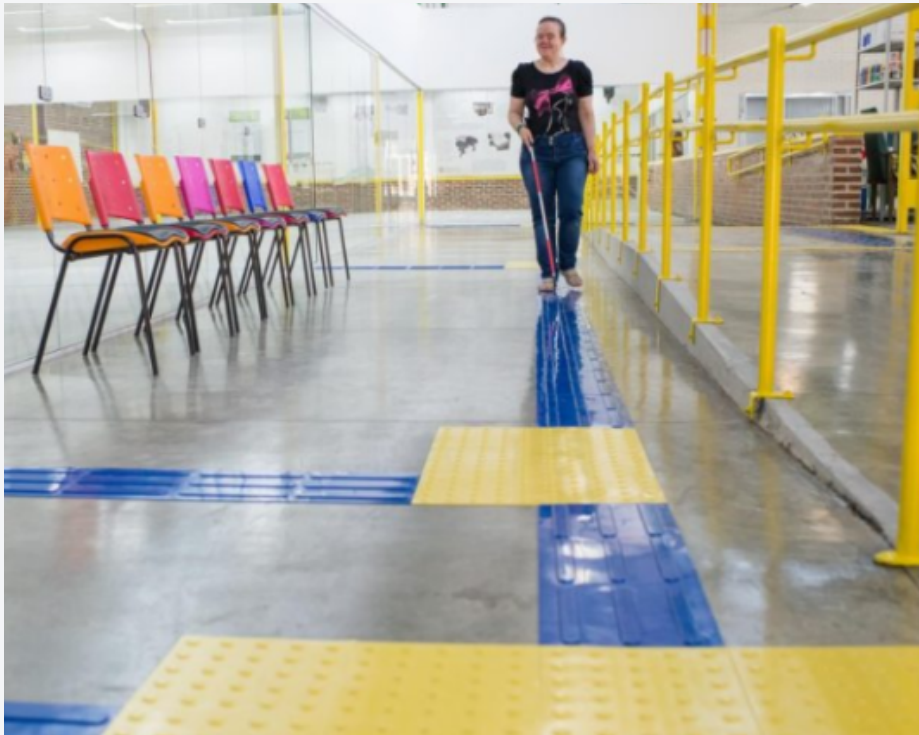
Figura 28 - Piso direcional e piso de alerta dentro de uma estrutura.
