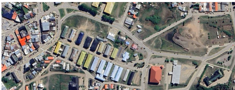
Figura 9. Imagen satelital del conjunto edilicio de las viviendas-pabellones en la actualidad.
