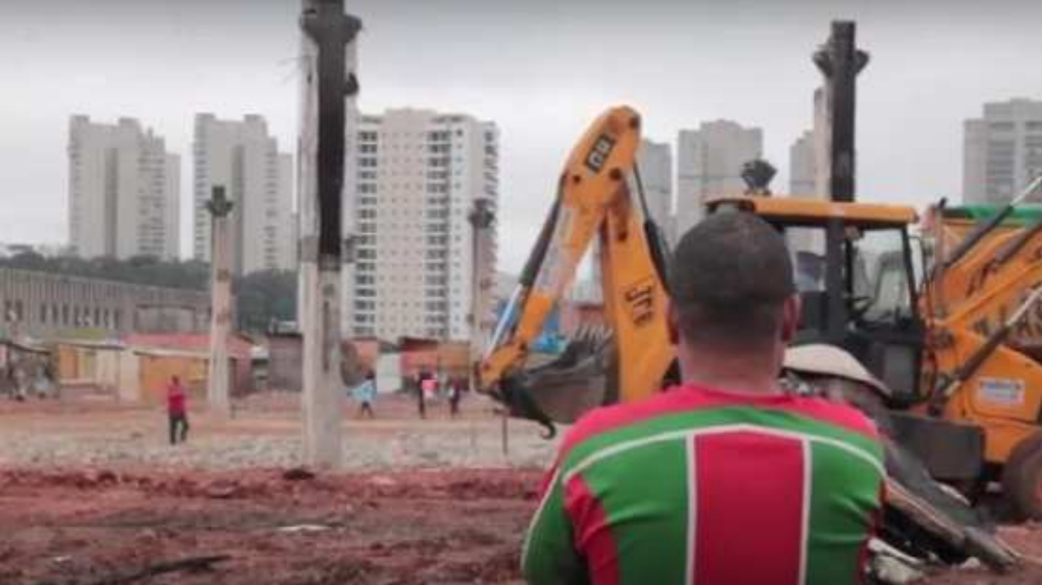
foto 3: preparo do terreno para demarcação dos lotes na ocupação Douglas Rodrigues. Equipe Juntos com Você, 2016.
