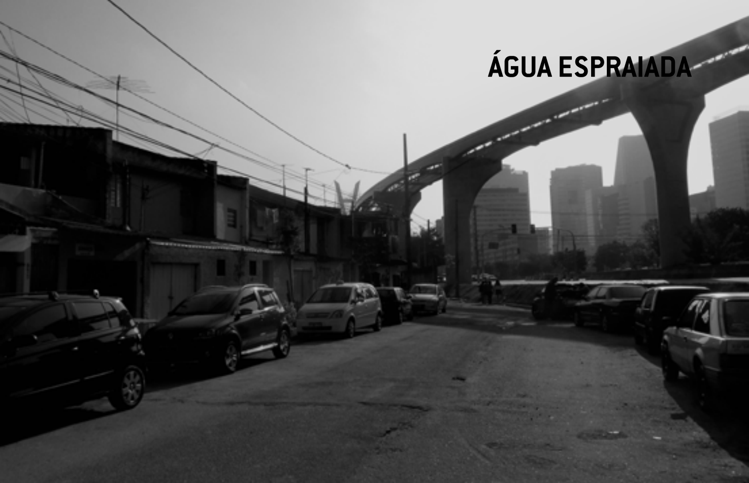
foto 1: vista da construção do monotrilho a partir da comunidade Bartolomeu Feio. Observatório de Remoções, 2016.
