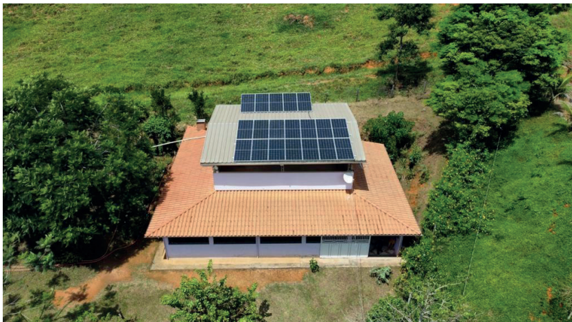
Figuras 93 e 94 – Microusina residencial de energia fotovoltaica
