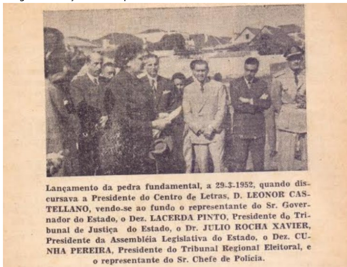
Figura 1 – lançamento da pedra fundamental do Centro de Letras do Paraná
