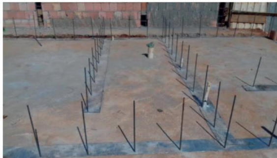
Figura 8 – Fixação dos arranques (Fonte: SALGADO, 2019)
