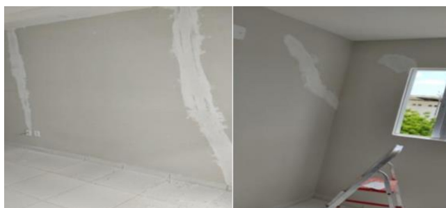
Imagem 3: Correção nas fissuras na parede.
