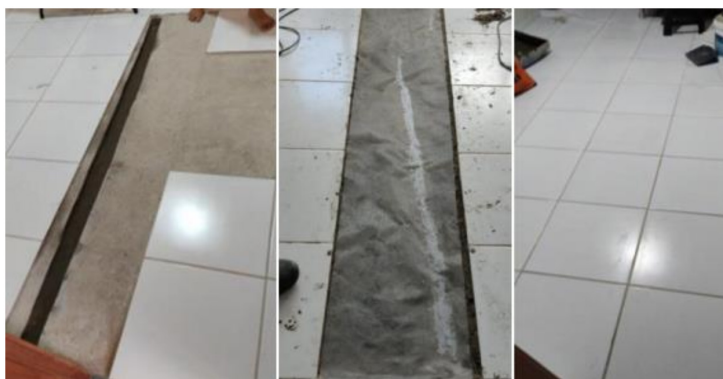
Imagem 1: Correção nas fissuras no piso.
