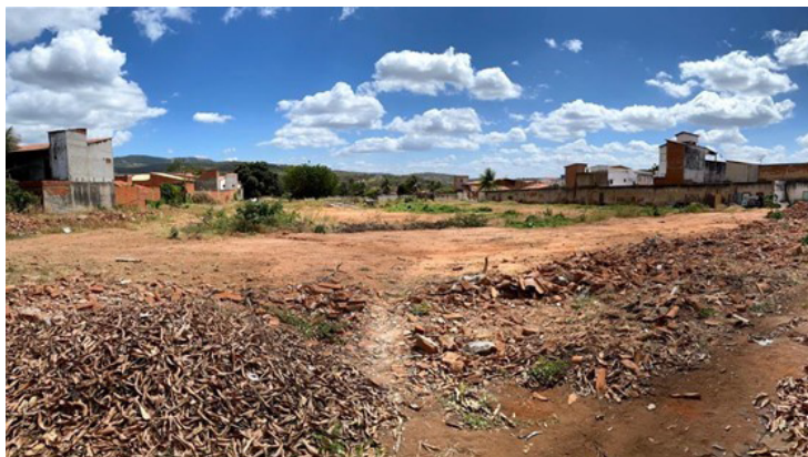
Figura 5.3 – Demolição da Casa de Saúde Santa Teresa em Crato, CE, lugar em que existiam os Pavilhões
