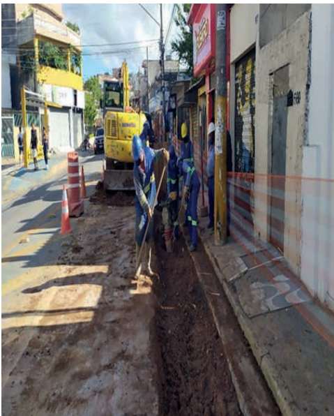
Figura 5: Escavação de Vala Processo VCA
