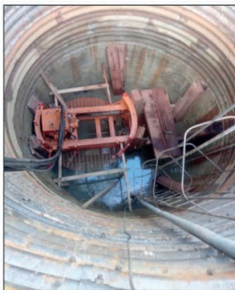
Figura 2: Instalação do Shield, processo Tubo Cravado
