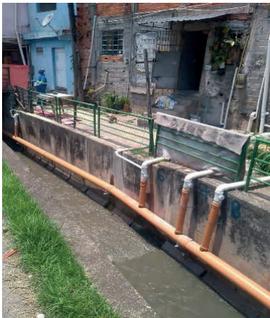
Obras civis para a implantação de redes coletoras e ramais
