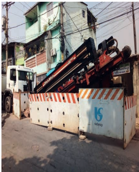
Figura 4: Processo Furo Direcional HDD
