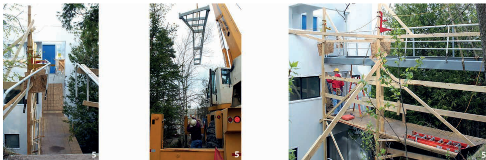
Figura 5. Casa Douglas. Restauração em 2008.
