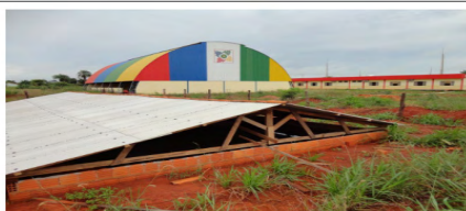
Figura 14. Cisterna de 125.000 litros com cobertura de telhas de Eternit.
