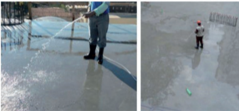
Figura 34 - Processo de lavagem da laje para manter a umidade durante o processo de pega do cimento
