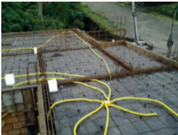
Figura 32 - Laje preparada com a passagens de conduítes e caixas de iluminação
