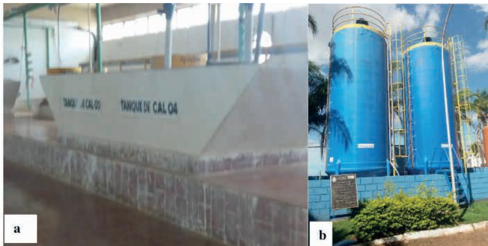
Figura 2: (a) tanque manual para adição de cal virgem em pó; (b) armazenamento de cal hidratada
