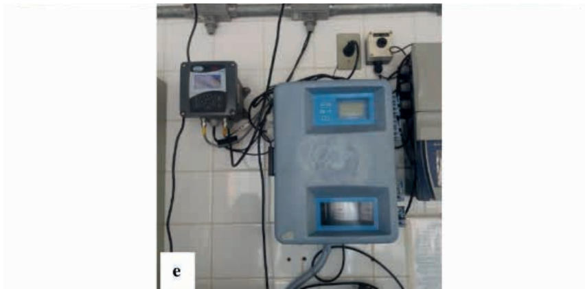
Figura 4: (a) sistema de controle de recepção de água bruta; (b) medidores de pH, cor, turbidez da água bruta e após o processo de coagulação e decantação em tempo real; (c) dosador de cal virgem e PACI; (d) distribuição da cal virgem e PACI na água bruta e (e) painel de controle, dentro do laboratório, que transmite informação de pH, cor, turbidez em tempo real para o operador; na ETA Bom Jardim - Uberlândia.
