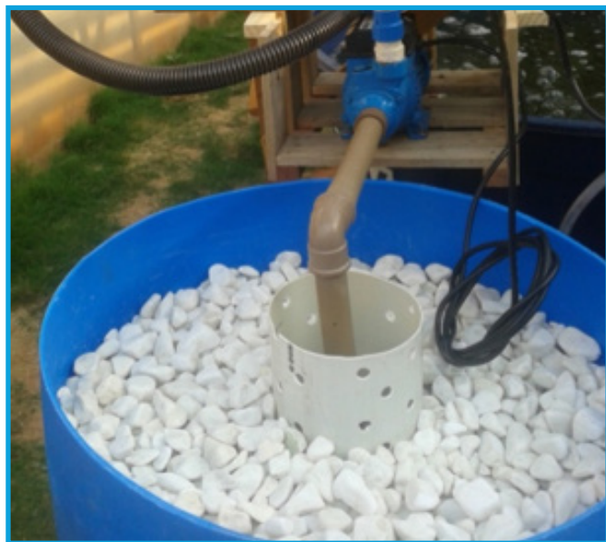
Figura 3 - Filtro biológico composto por pedras para melhor fixação das bactérias nitrificantes.
