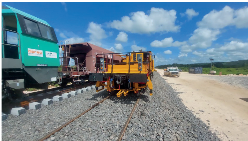
Figura N° 4: avance de obra del Tren Maya.
