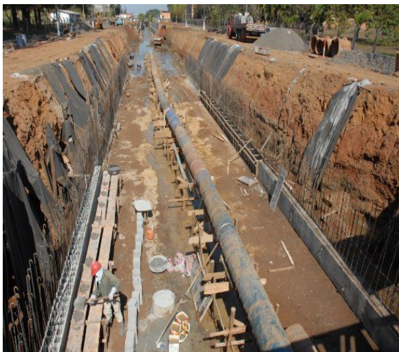
Figura 4. Início das obras de canalização Gamelinha.
