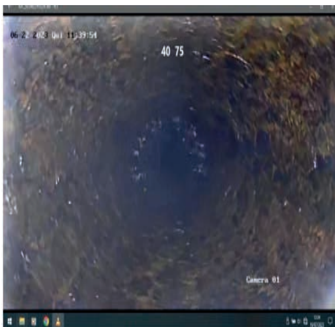
Figura 6: mostra revestimento comprometido e saída de água abaixo dos 40,75 metros de profundidade
