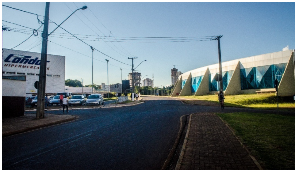
Figura 108 – Arena multiuso implantada no canteiro da Avenida dos Vereadores e supermercado construído em frente (Martha Batista, 2019).
