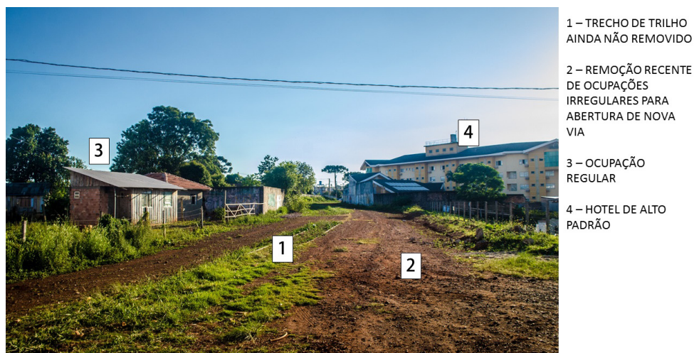
Figura 36 – Residência em local irregular, na faixa de domínio da ferrovia (Martha Batista, 2019).
