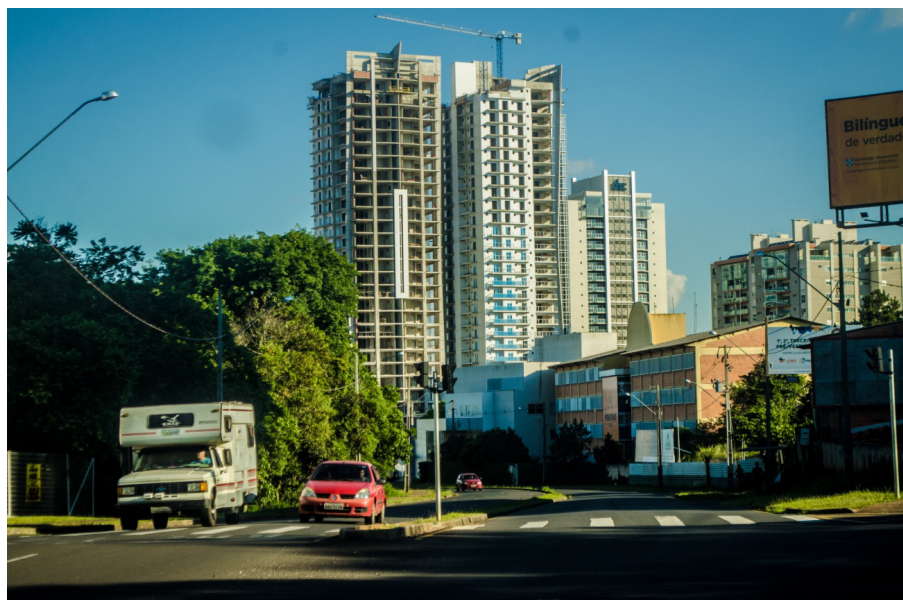
Figura 14– Edifícios de luxo de grande porte, localizados nas proximidades da Avenida dos Vereadores, antiga ferrovia (Martha Batista, 2019). Nota: Todos os edifícios da fotografia tiveram suas obras iniciadas a partir do ano de 2015.
