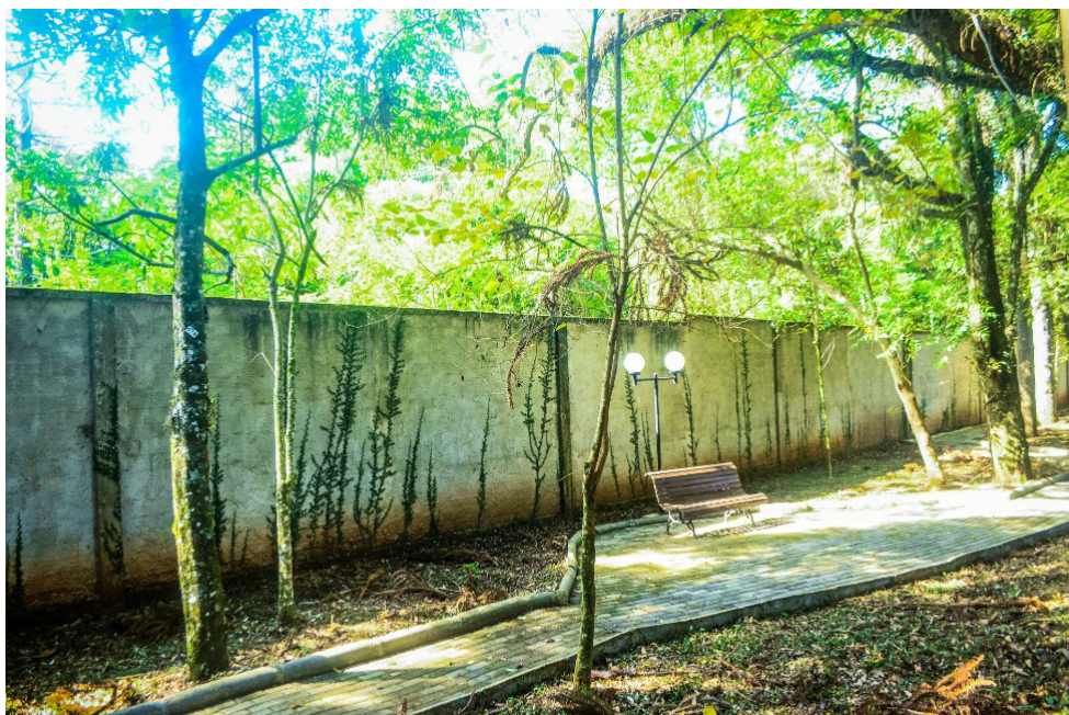
Figura 96 – Trilha e muro de divisa entre o Condomínio e a Área de Preservação do arroio (Martha Batista, 2019).
