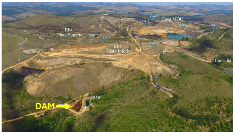
Figura 2. Vista do BotaFora 4 (BF4) e da surgência da DAM na base da BF4. (Extraído de Alberti, 2017).
