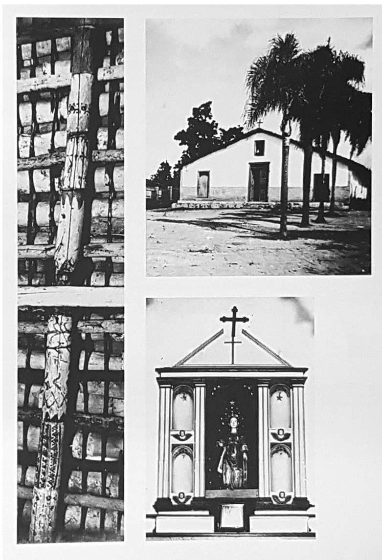
Figura 6 – Capela da antiga aldeia de Carapicuíba, em São Paulo
