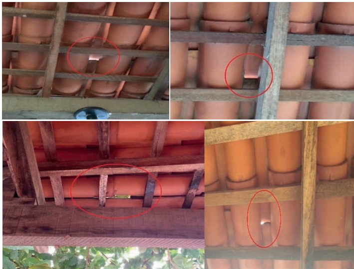
FIGURA 3. Baldosas mal colocadas
