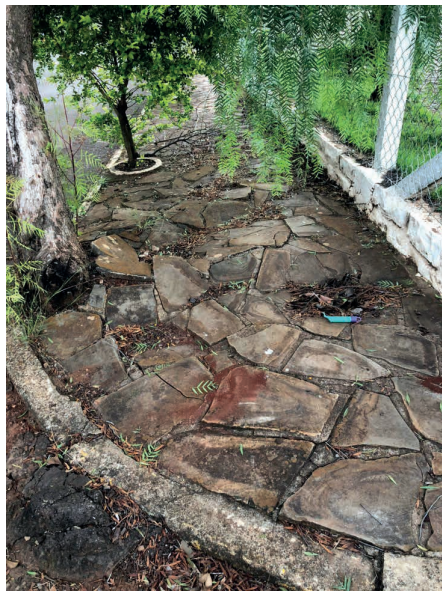
Figura 14: Fonte: Oliveira, I. Calçada.
