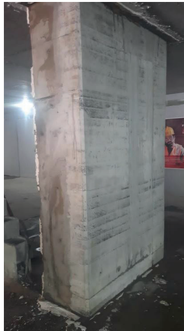
Figura 6 - Seção do pilar reforçada.
