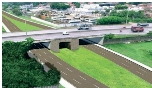
Figura 4 – Viaduto da Enel: ligação da rua 117 no setor Leste Universitário à Avenida Rio Preto no Jardim Novo Mundo.
