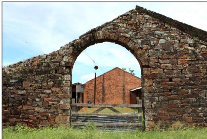
Figura 4. Estrutura com abertura em alto arco romano. Fonte: acervo do IAP.
