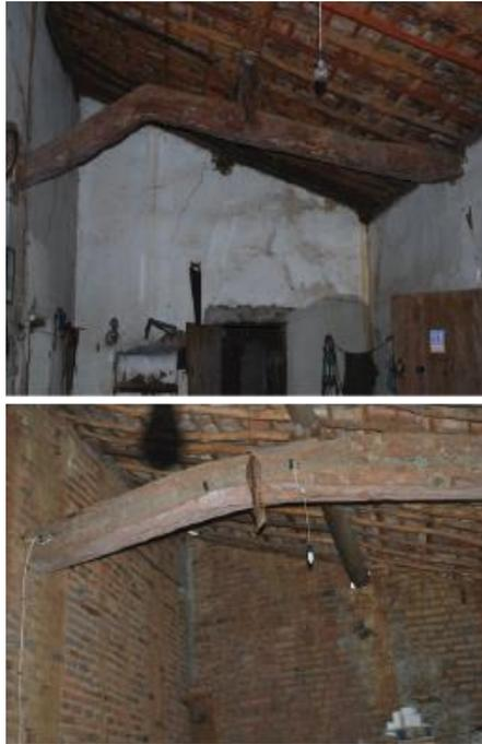
**Figura 69** – Elemento estrutural brabo
