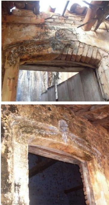
**Figura 62** – Pormenor dos revestimentos da casa-grande Dinamarca
