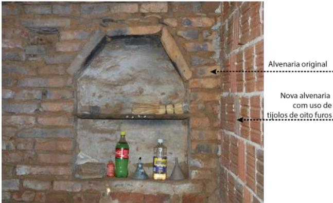
**Figura 57** – Alvenarias original e nova da casa-grande Encampinado
