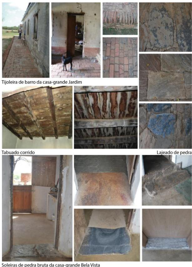
**Figura 61** – Pisos utilizados nas casas-grandes dos conjuntos rurais do Seridó Potiguar
