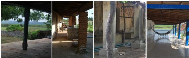
**Figura 37** – Estrutura dos pilares dos alpendres: madeira, tijoleira de barro, alvenaria e PVC, respectivamente
