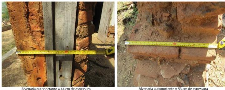
Alvenaria autoportante = 44 cm de espessura
