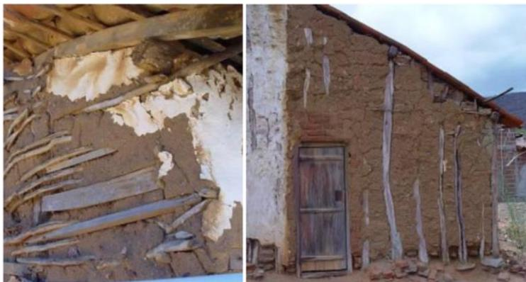
**Figura 25** – Sistema construtivo em taipa
